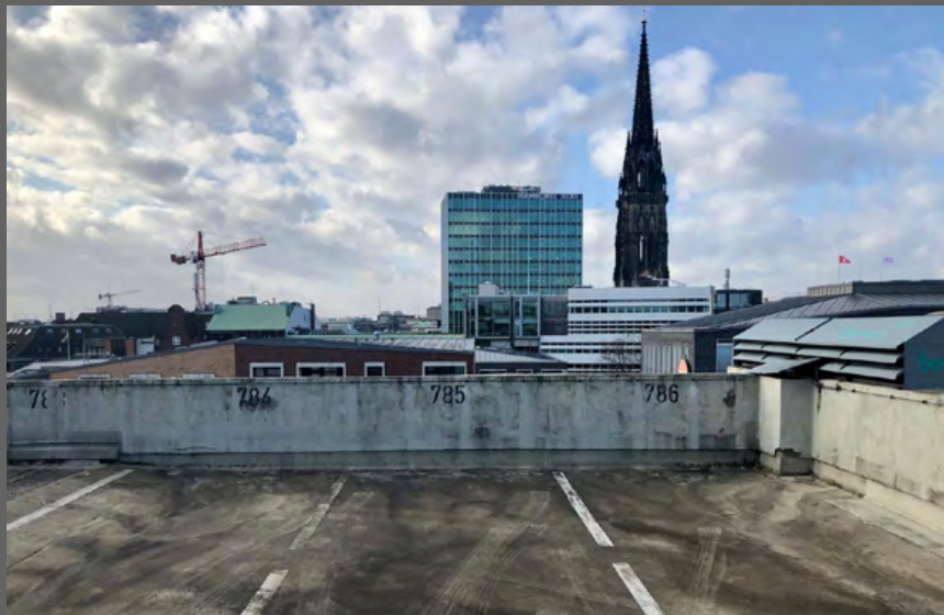
Abb. 1 Parkhaus Neue Gröninger Straße 12, Gröninger Hof eG, Foto: Kai Ratschko
